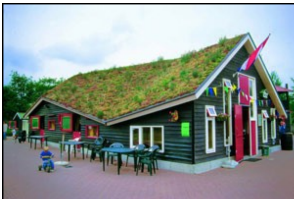
Figura 05- Cobertura extensiva com sedums - Fonte: www.igra-world.com > Engineering Special Construction
