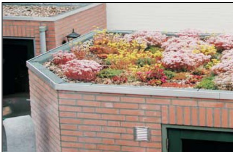
- Figura 07- Detalhe da cobertura extensiva - Fonte: Greentex – www.texsa.com
